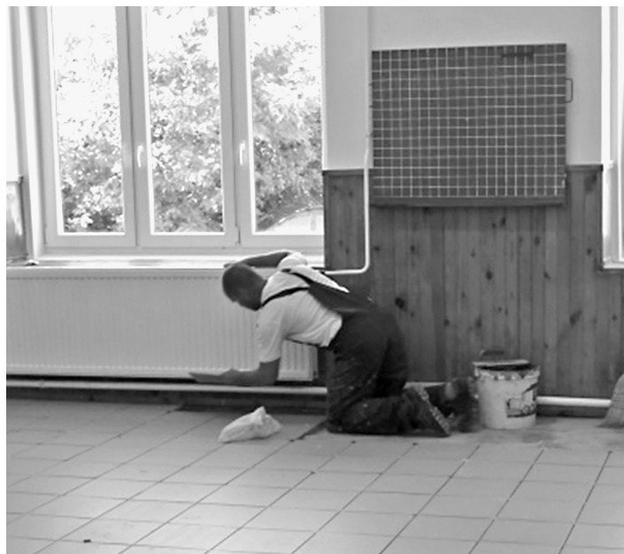
Osztályterem felújítása a Zrínyi úti iskolában
