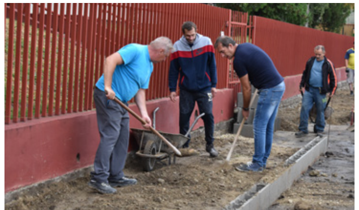
Járdaépítés a Zrínyi úti iskolaépület előtt
