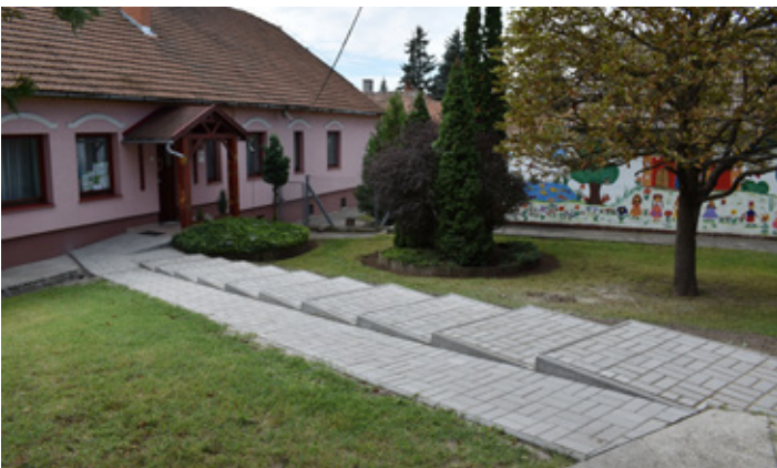
Járdafelújítások az óvodaudvaron
