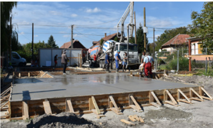
Az orvosi szolgálati lakás építése megkezdődött
