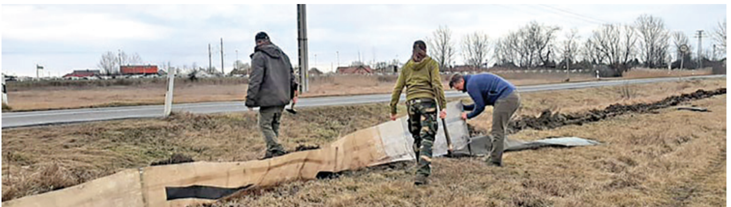
Békaterelő kerítés állítása a 311-es út mentén
