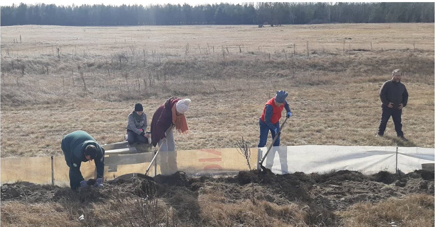
Békaterelő kerítés építése a 311-es út mentén
