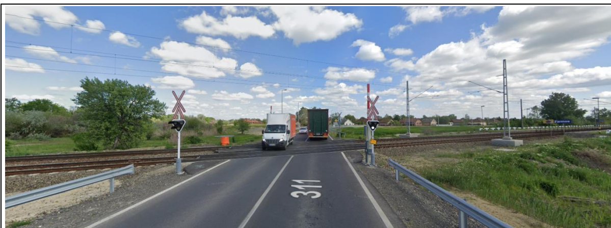
A 311. sz. főút új nyomvonalán kialakított szintbeli vasúti kereszteződés a vasútállomástól nyugatra
