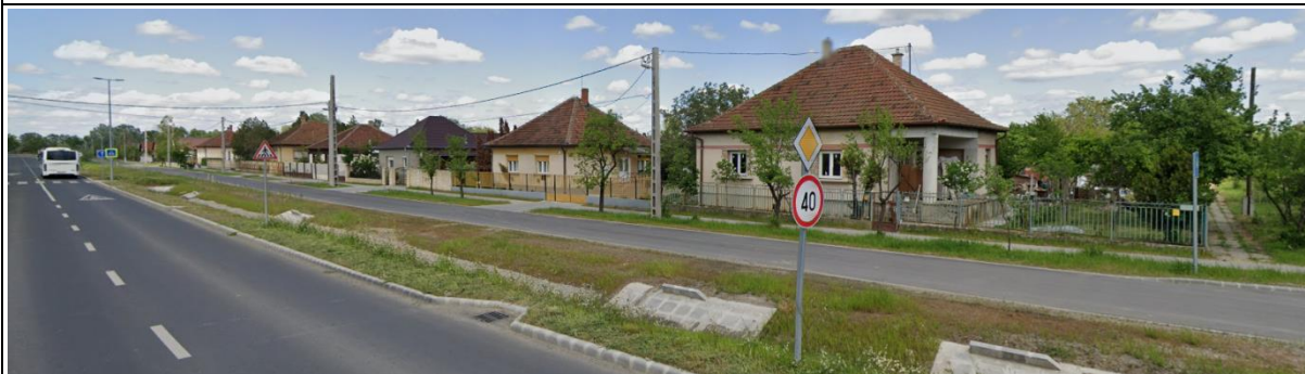
A 311. sz. főúttal párhuzamos Vasút sor falusias lakóterület
